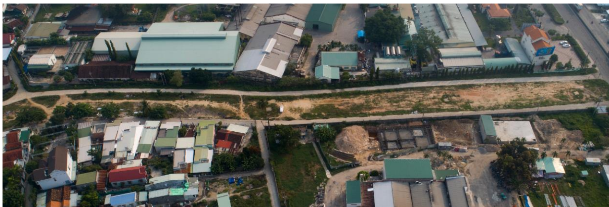
Hình 25. Tuyến kênh Cầu Đôi Suối Dầu tại khu vực dự án sản xuất kinh doanh nước dinh dưỡng các loại (đoạn đã hạ ngầm)
