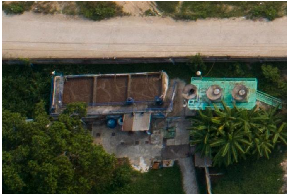
Hình 15. Hiện trạng hoạt động của trạm XLNT tại cơ sở
