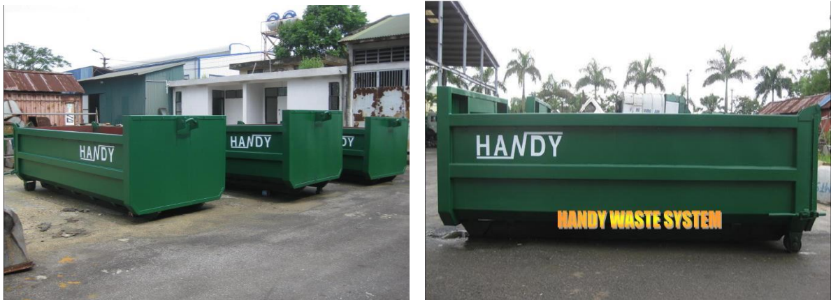
Hình 31. Hình ảnh thùng ben chứa phế thải xây dựng 5 m 3 tại công trường thi công dự án
